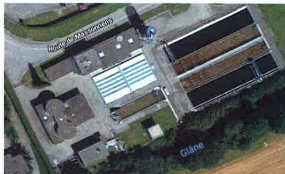
Avec la station d'épuration de Romont
